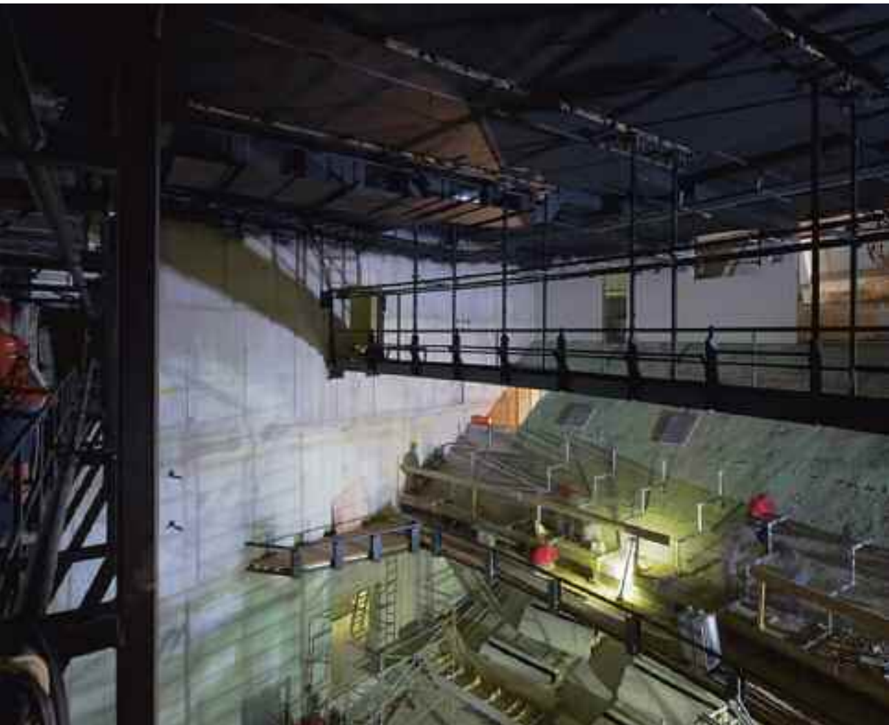
De kleine zaal van het DeLaMar Theater in aanbouw
